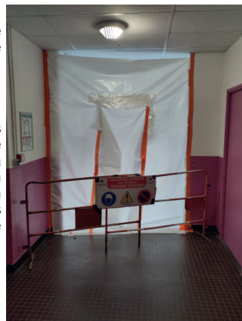
Le collège Jean Vilar pendant les travaux
